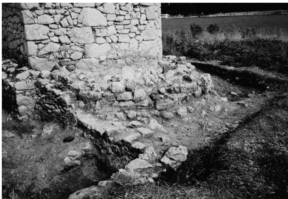
Zidovi iz starije faze gradnje otkriveni s vanjske strane kapele nakon čišćenja
