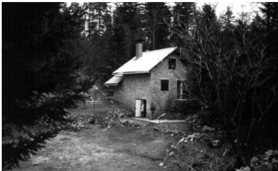
Obnovljena kuća va Gori
