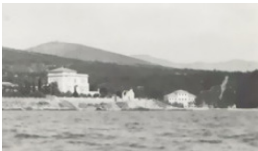
Na slici u prvom planu vila Odilon a desno kasarna. Prvi je objekt posve porušen a drugi dijelom obnovljen.
