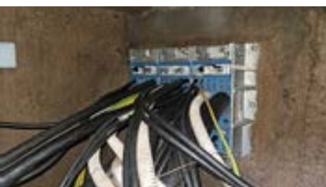
Slika 4. Nakon brtvljenja modularnim brtvenim sustavom
