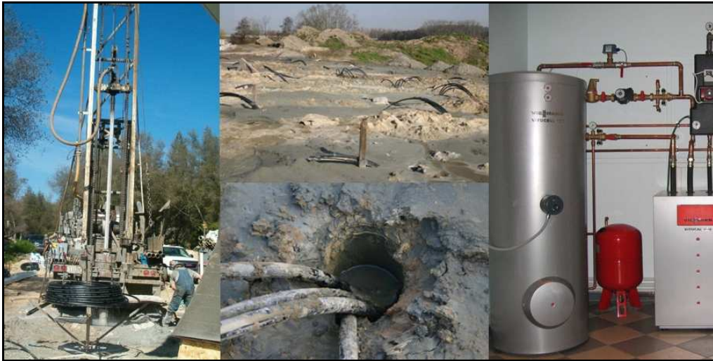
Slike 3-5: Pregled bušćih radova pri instaliranju U-izmjenjivača topline i ugrađena toplinska pumpa
