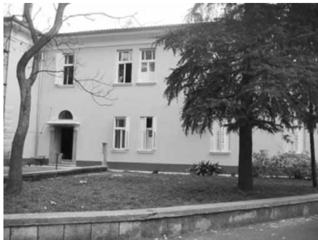
Slika 2. Završni radovi na fasadi Klinike (2007. god.)
