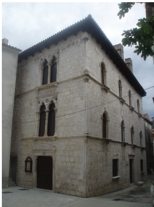
Slika 1. Pogled na zapadno pročelje i južnu bočnu fasadu kuće Arsan (Marcello-Petris) u Cresu
