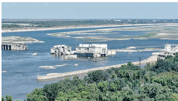
Slika 1: Pogled na srušeni dio brane Kahovka
