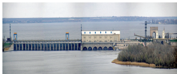
Slika 3: Pogled uzvodno na betonski dio brane i jezero
