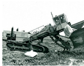
Slika 21: Drenmaster – stroj za ugradnju drenažnih cijevi sustava podzemne odvodnje, 1979. godine
