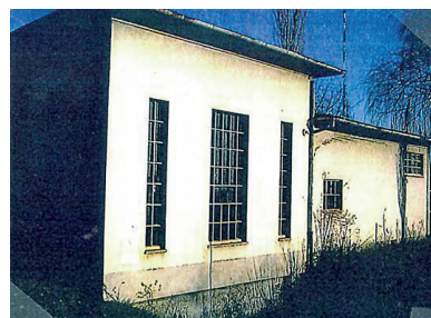
Slika 8: Crpna stanica za navodnjavanje voćnjaka Borinci
