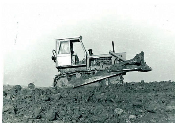
Slika 14: Dozer na razastiranju zemlje na regulaciji Biđa, 1970. godina
