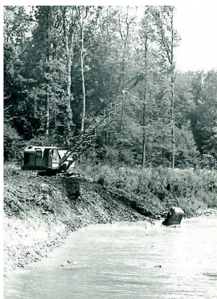
Slika 13: Bager "dragline" na regulaciji vodotoka Brižnica, 1979. godina
