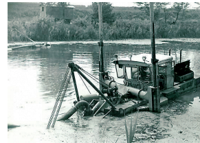
Slika 17: Plovni bager na izmuljenju korita Bosuta u Cerni, 1970. godina
