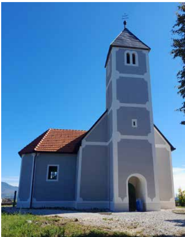
15 Veliki Komor, kapela sv. Benedikta, pročelje nakon obnove (foto: A. Radelić, KO KR, 2024.)
