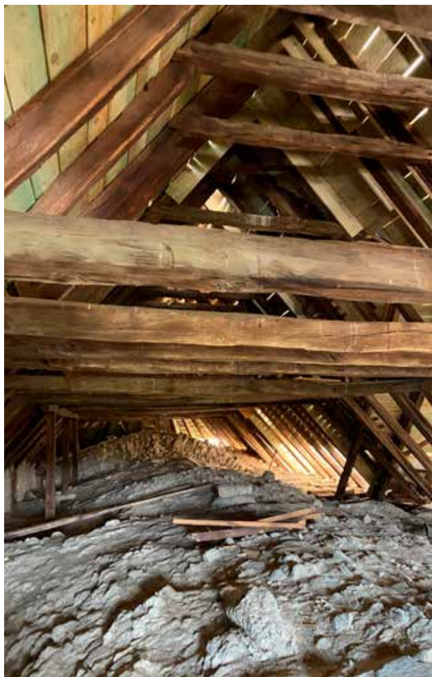
8 Hrašćina, župna crkva sv. Nikole, krovšte nakon sanacije parcijalnom zamjenom i dodavanjem drvenih elemenata (foto: V. Jakaša Borić, KO KR, 2023.)
