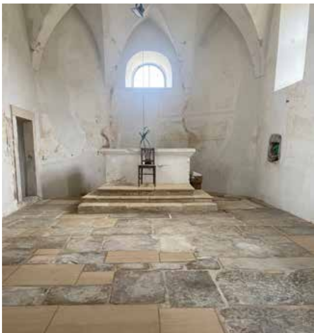
13 Lenište, kapela sv. Margarete, povijesni pod nakon obnove (foto: V. Jakaša Borić, KO KR, 2024.)
