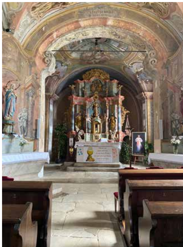
1 Hrašćina, župna crkva sv. Nikole, interijer nakon radova konstrukcijske sanacije (foto: V. Jakaša Borić, Konzervatorski odjel Krapina, 2024.)
