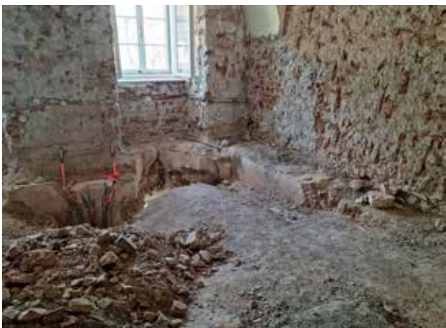
9 Ostaci gotičkih prozora i rebara svodova nekadašnje kapitularne dvorane samostana sv. Franje Asiškog na Kaptolu (Fototeka, GZZSKP, 2021.)
