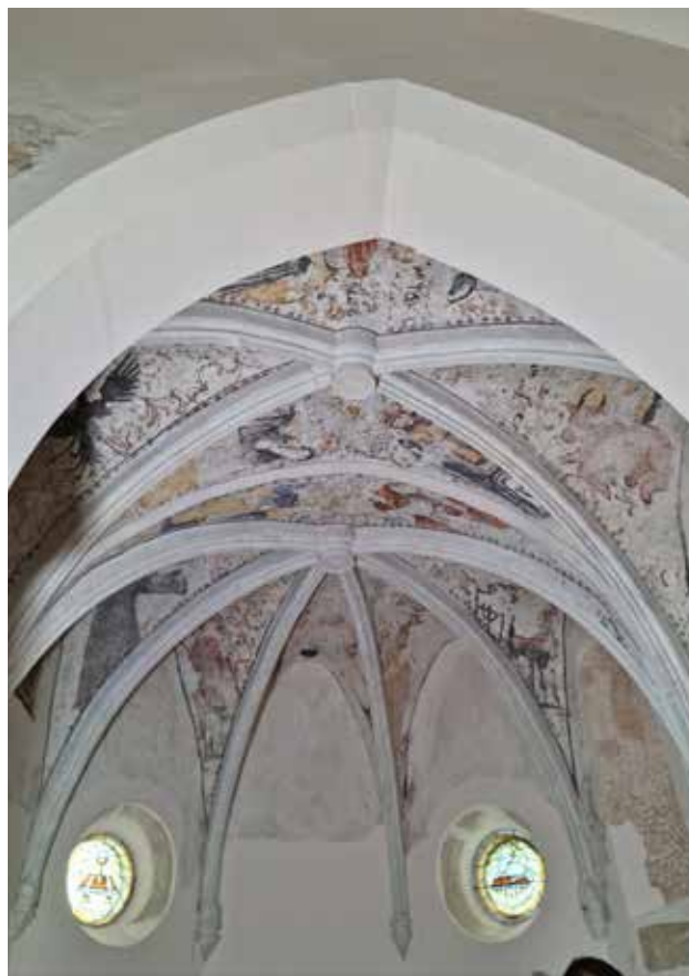
12 Svod svetišta crkve sv. Šimuna i Jude Tadeja u Markuševcu nakon izvedenih restauratorskih radova 2023. (Fototeka, GZZSKP, 2023.)
