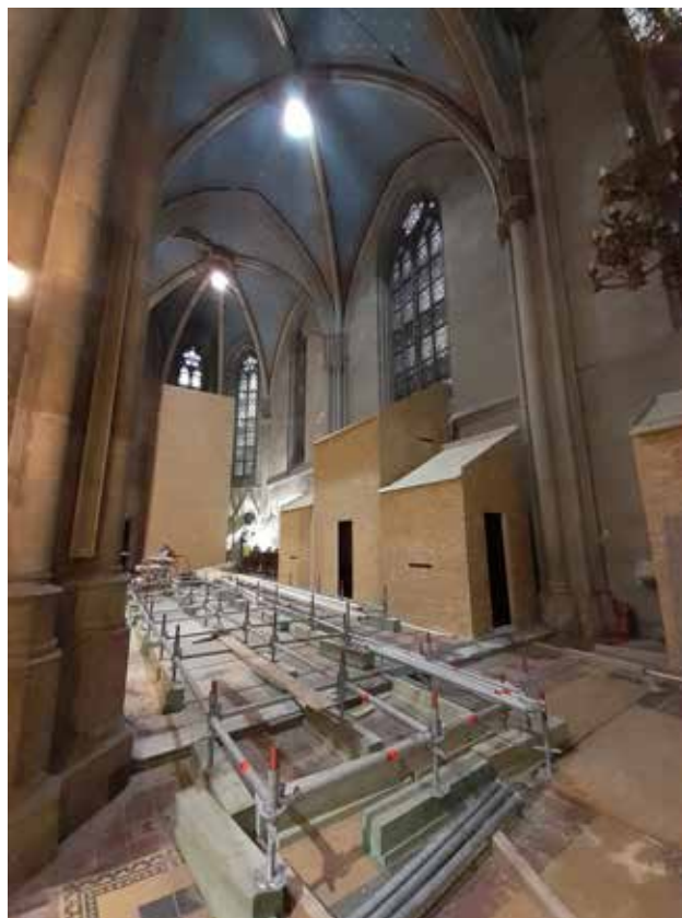
2 Drvene zaštitne oplata oltara na južnom zidu katedrale Uznesenja Marijina na Kaptolu (Fototeka, GZZSKP, 2020.)
