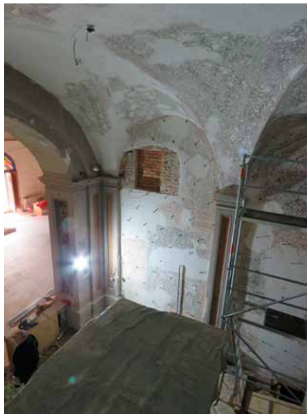
16 Kapela sv. Antuna Padovanskog, pogled na bočni zid restauratorski stabiliziran i pripremljen za građevinsko injektiranje (foto: S. Kočevar, KO KA, 2024.)
