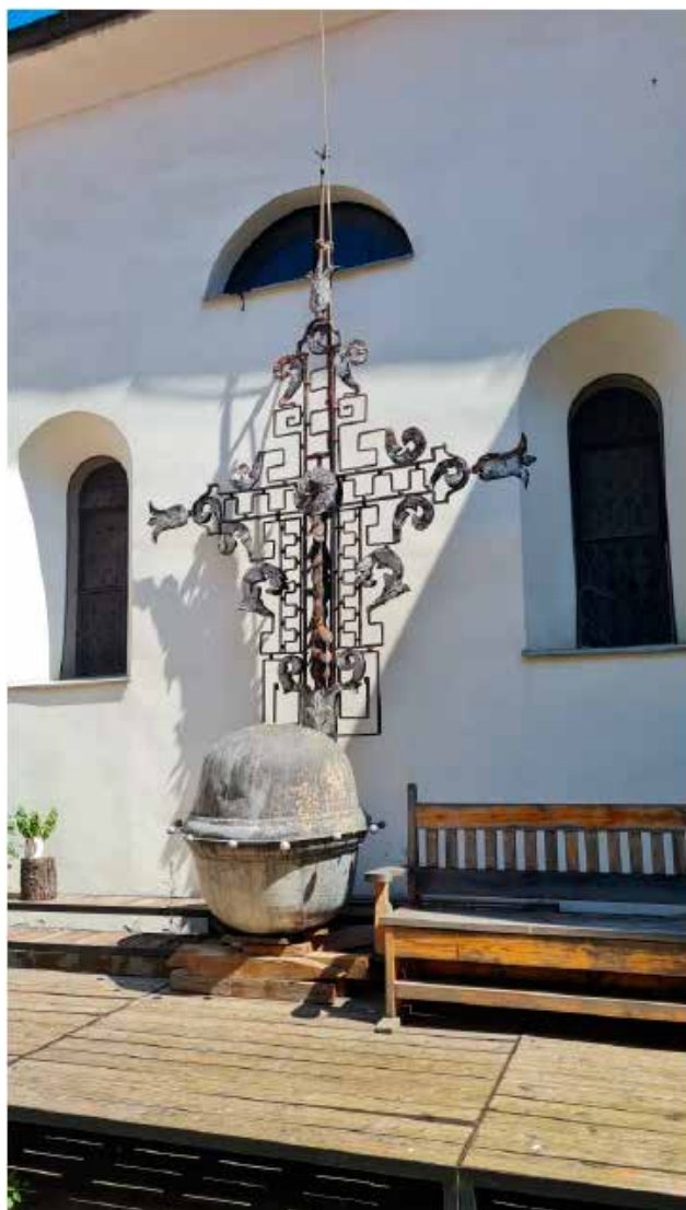
11 Križ i jabuka prije restauracije u klausturu franjevačkog samostana (foto: L. Ivančević, Ferrum d.o.o. 2021.)
