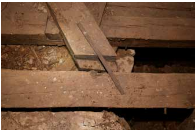
7 a i b Tamo gdje su spojevi potpuno otvoreni ranijim djelovanjima sila (lijevo) ili potresom (desno), potrebno je zamijeniti cjelokupne elemente ili njihove dijelove do spoja (foto: H. Turkulin, 2021.)
