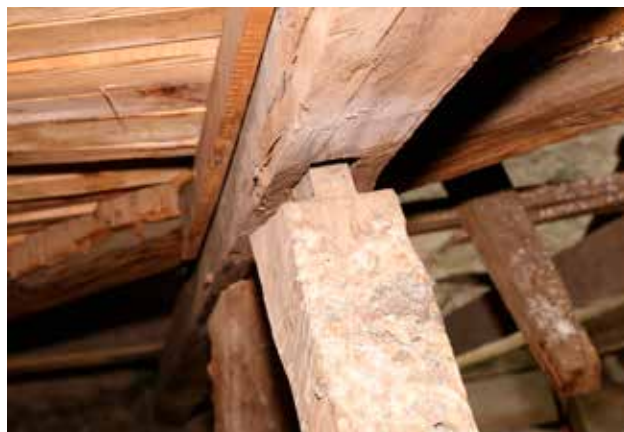
7 a i b Tamo gdje su spojevi potpuno otvoreni ranijim djelovanjima sila (lijevo) ili potresom (desno), potrebno je zamijeniti cjelokupne elemente ili njihove dijelove do spoja (foto: H. Turkulin, 2021.)
