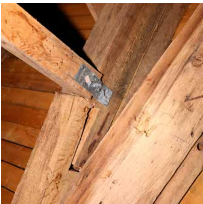
8 a i b. Na mjestima oštećenja krovišta bombardiranjem načinjeni su zahvati potpuno neadekvatne sanacije, kako s povijesno-tehničkog stajališta, tako i s aspekta zahtjeva pravilne tesarke tehnike i kvalitete izrade. Vidljiva su privremena podupiranja, neispravno izvedeni spojevi i pruručno osiguranje skobama i metalnim vezicama. Projektom sanacije ovakve elemente treba zamijeniti, a dijelove krova obnoviti adekvatnim drvenim dijelovima i spojevima (foto: H. Turkulin, 2021.)
