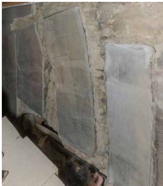
12 Izvedeni facing na naslikanom medaljonu iznad nadvoja prozora na zapadnom zidu (foto: Katarina Gavrilica, HRZ, 2023.)
