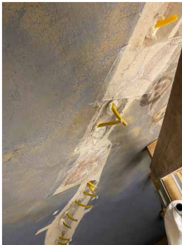
16 Građevinsko injektiranje (foto: Katarina Gavrilica, HRZ, 2023.)
