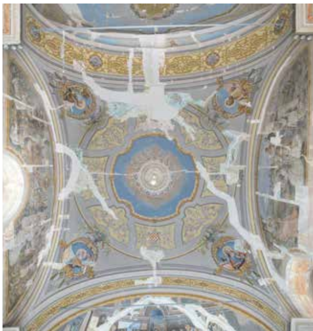
18 Svod svetišta nakon završenih radova (foto: Katarina Gavrilica, HRZ, 2023.)
