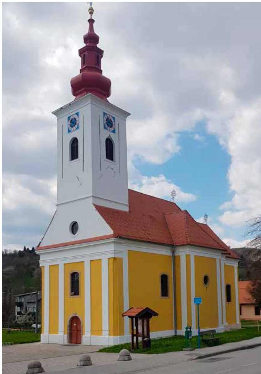
1 Vugrovec, župna crkva sv. Franje Ksaverskog nakon potresa (foto: S. Novak, Gradski zavod za zaštitu spomenika kulture i prirode – dalje GZZSKP, 2020.)
