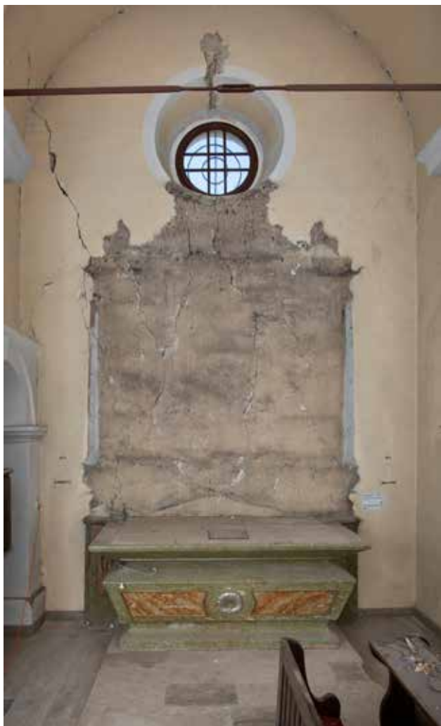
7 Vugrovec, župna crkva sv. Franje Ksaverskog, bočni oltar Majke Božje nakon demontaže retabla i atike (foto: N. Oštarijaš, HRZ, 2020.)
