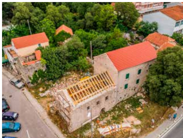
3 Pogled na sklop Serdarovih kuća 2018. godine tijekom radova sanacije (fototeka CKB grada Vrgorca, 2018.)
