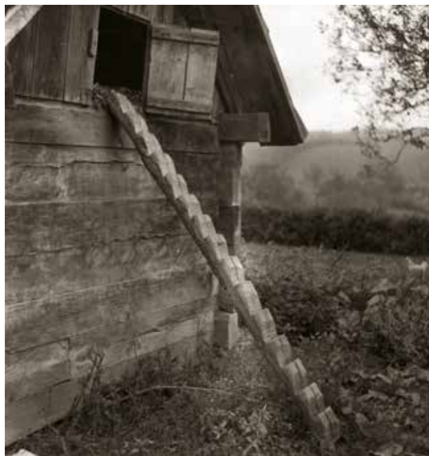
16 Lukinić Brdo kbr. 118; stepenice istesane iz jednog komada drveta (foto: N. Vranić, 1972.)
