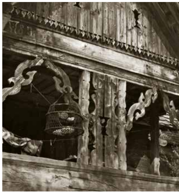
12 Kozjača kbr. 18; trijem kuće sa košarom za sušenje sira (foto: N. Vranić, 1972.) Kozjača No. 18; porch of the house with a basket for drying cheese (photo: N. Vranić, 1972)
