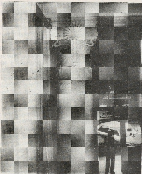
Hotel »Miramare«, stup na ulaznom stubištu
