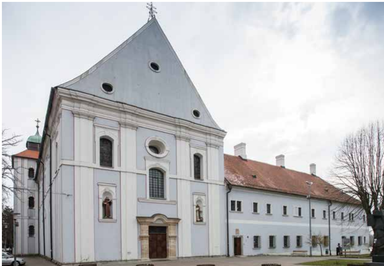
13. Slavonski Brod, franjevačka crkva Presvetog Trojstva, pročelje (foto: Paolo Mofardin) Slavonski Brod, Franciscan church of the Holy Trinity, front façade
