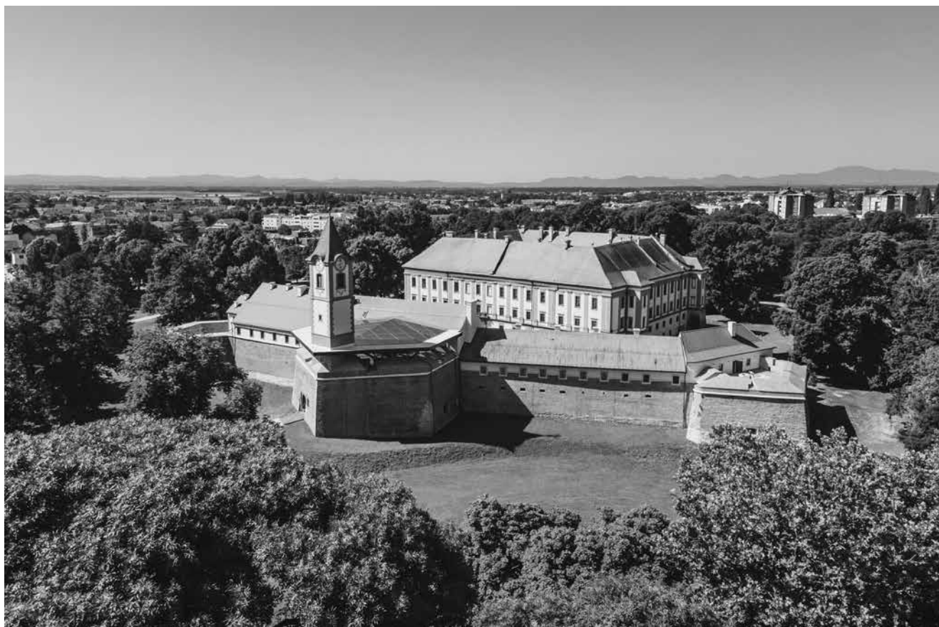
1. Sklop Staroga grada u Čakovcu (izvor: Muzej Međimurja Čakovec) The Old Castle complex in Čakovec
