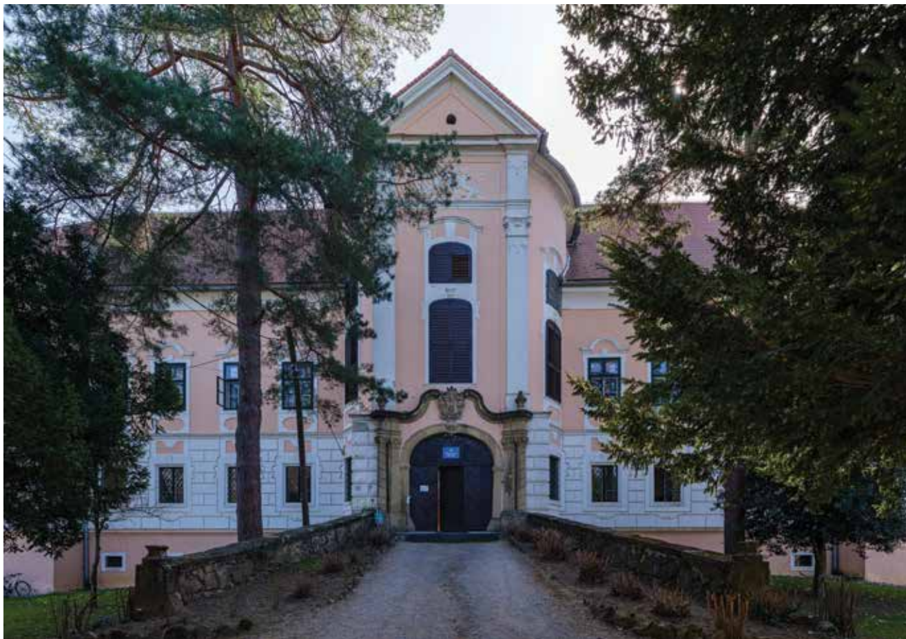
1. Dvorac Gornja Bistra, glavno pročelje (foto: Paolo Mofardin) Gornja Bistra Manor, main façade
