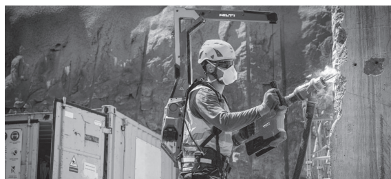
Slika 7. Egzoskelet za nošenje težeg građevinskog alata
