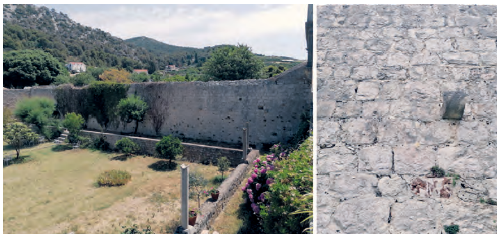
Istočni ogradni zid vrta sa šetnicom i detalj istočnog ogradnog zida s konzolom
