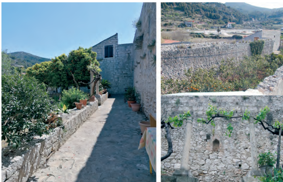
Južni ogradni zid - prolaz između kuća; izvana; detalj
