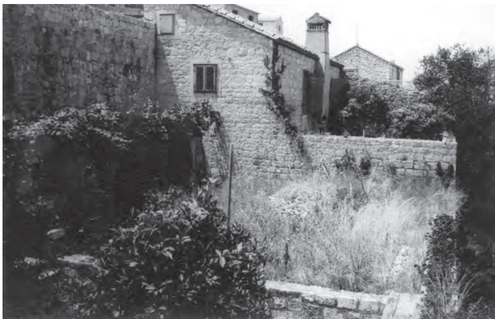
Zapadna kuća 1970., pogled s istoka
