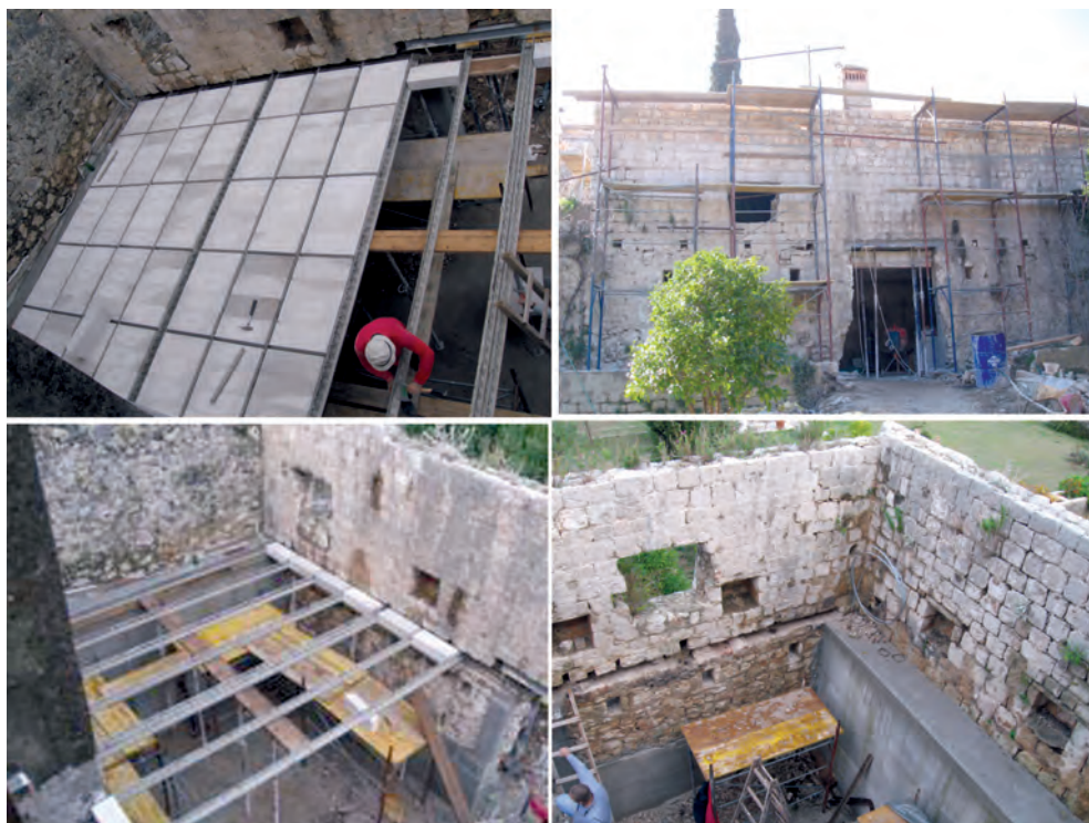
Radovi na rekonstrukciji zapadnog krila Ljetnikovca
