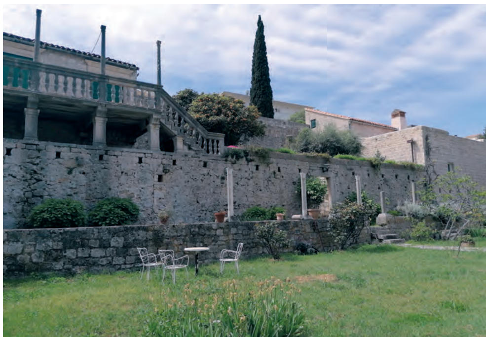
Južni potporni zid
