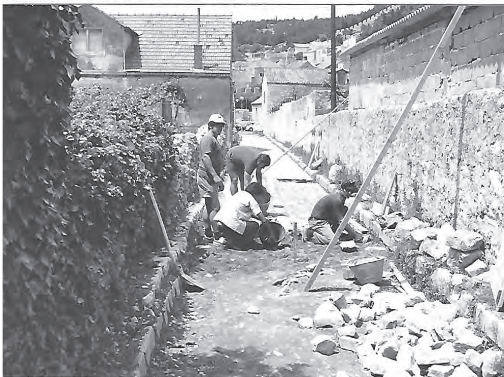
Ulica Hanibala Lucića, popravak pločnika, 1978.
