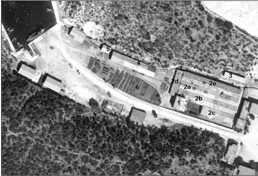
Slika 8: Zračni snimak Ubla 1968. s označenim dijelovima tvorničkog kompleksa (Geoportal).
