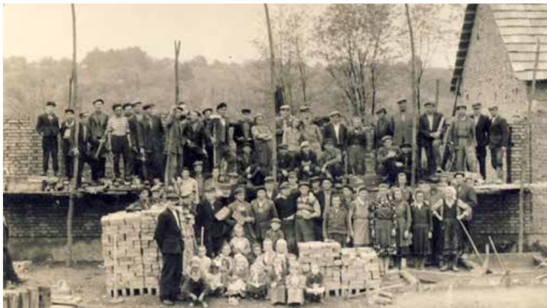
Sl. 3. Sudionici izgradnje prvog vatrogasnog spremišta u Hrastovskom.
