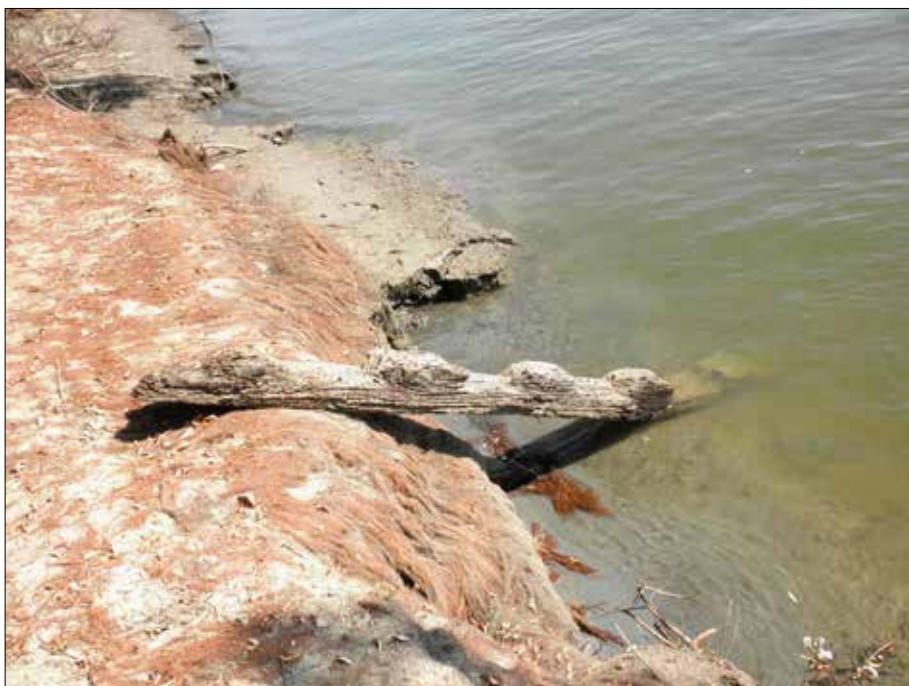
13. Drvena greda uz stup VI (foto Igor Vukmanić, 2011.)
