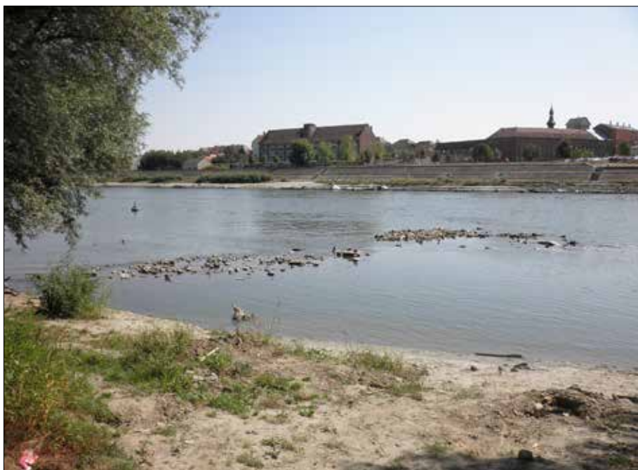
3. Ostatci stupova VI i V mosta u Mursi (foto Igor Vukmanić, 2011.)
