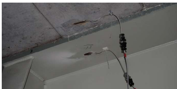
Slika 19. - Mjerne trake za mjerenje deformacija na betonskoj i čeličnoj konstrukciji
