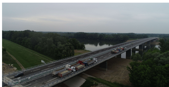
Slika 13. - Postavljanje opterećenja u položaj za statičko ispitivanje
