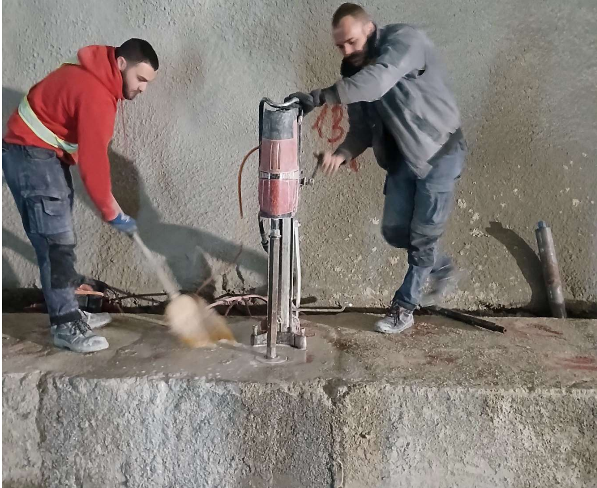
Slika 3. Uzimanje jezgrenih uzoraka sa lokacija 1 i 21 i priprema za laboratorijska ispitivanja [izrada autora].
