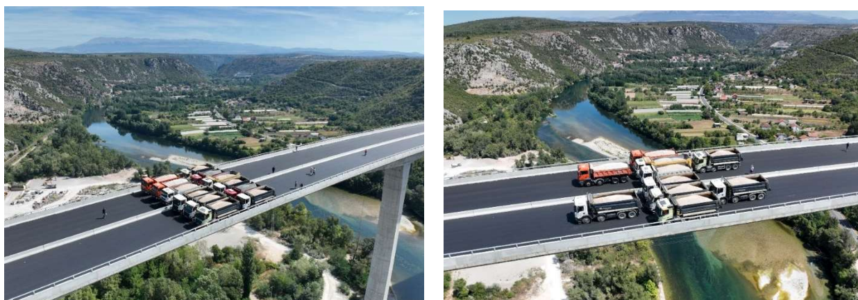
Slika 12. - Postavljanje opterećenja u položaj za statičko ispitivanje
