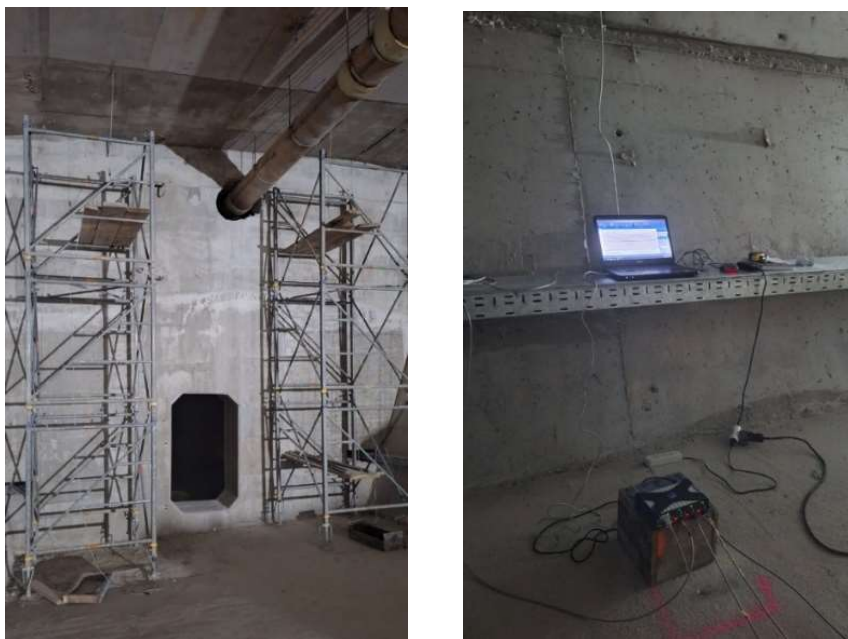
Slika 25. - Provedba ispitivanja probnim opterećenjem
