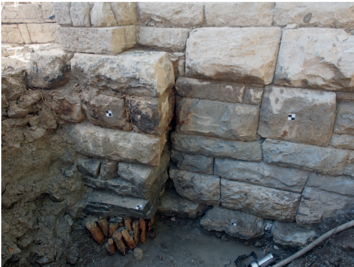
Sl. 14 Presloženi segment bedema i drvenih pilota koji ga učvršćuju (snimio: N. Romac) Fig. 14 Rebuilt segment of the wall and the wooden piles reinforcing it (photo by: N. Romac)
