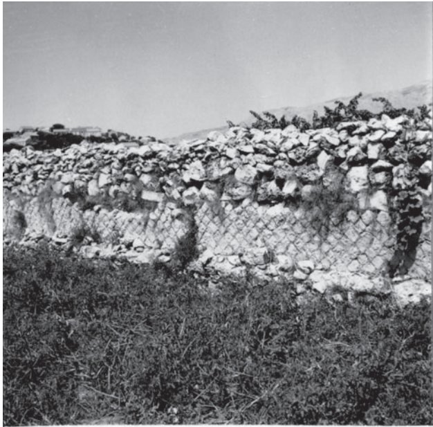
Sl. 4 Zid izgrađen tehnikom opus reticulatum , lokalitet Velo poje 1968. godine (snimio: prof. A. Rendić-Miočević; pohrana: ARHINDOKS Instituta za arheologiju)
