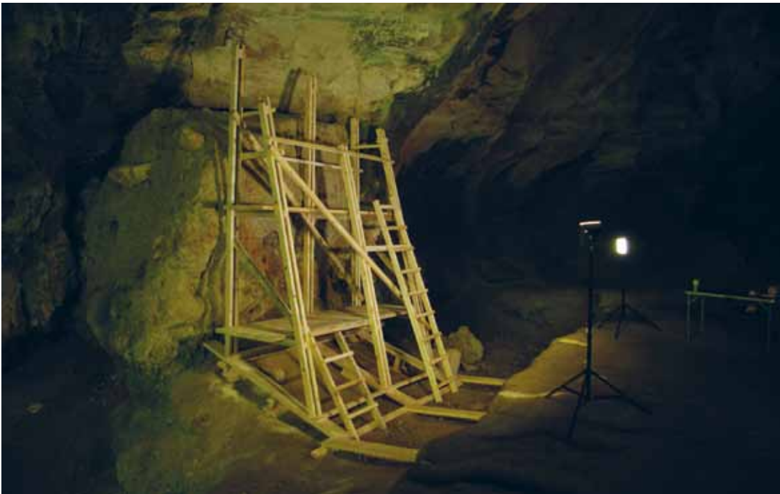
SLIKA 2. Drvena skela postavljena uz profil 3 za potrebe iskopavanja (snimila F. Sirovica).
