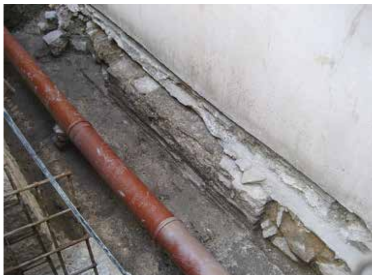
Sl. 18. Lezena zapadnog zida dvorane za audijencije pronađena u dvorištu kuće u Alješijevoj 5
