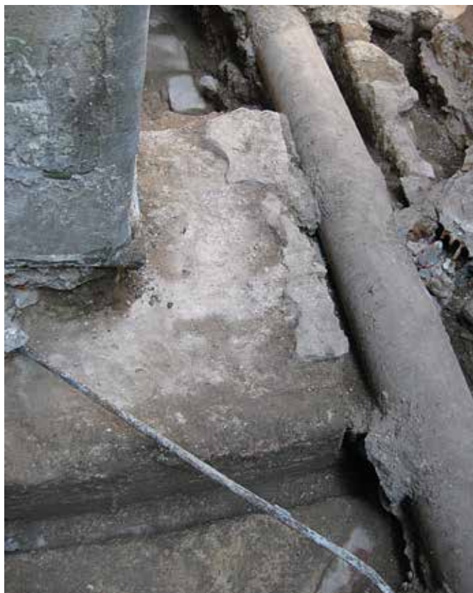
Sl. 10. Sonda br. 1. Sačuvano je unutarnje lice zapadnog zida dvorane za audijencije i otisak u podu gdje su stajale mramorne zidne obloge. U podu se vidi i sačuvani ulomak keramike postavljen pod kutom od 45°.
