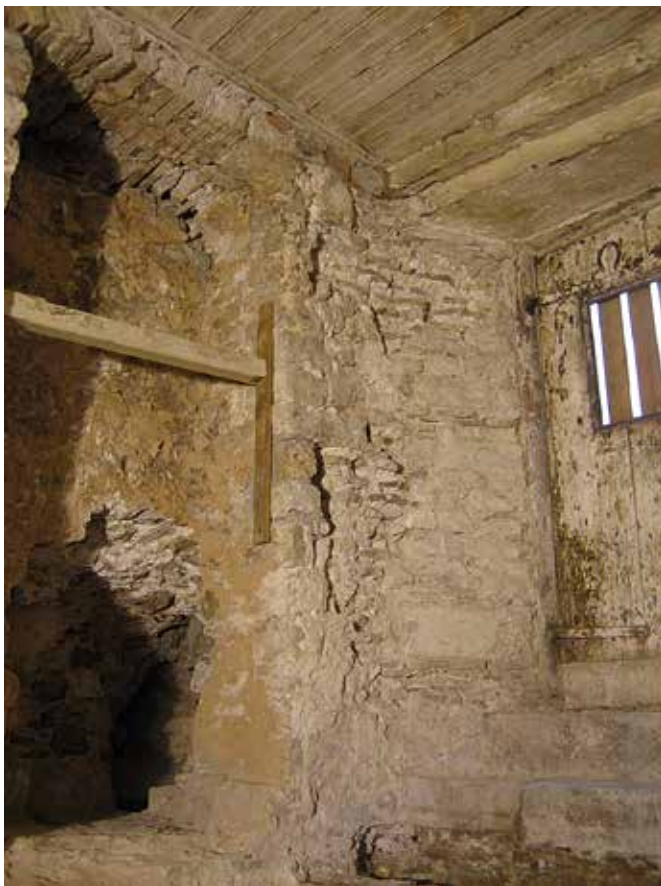
Sl. 22. Sačuvani antički dio zida građen opekom
