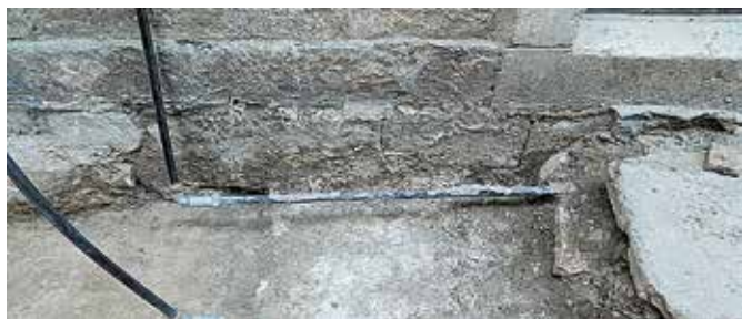
Sl. 17. Temeljni zid od fino klesanih blokova
