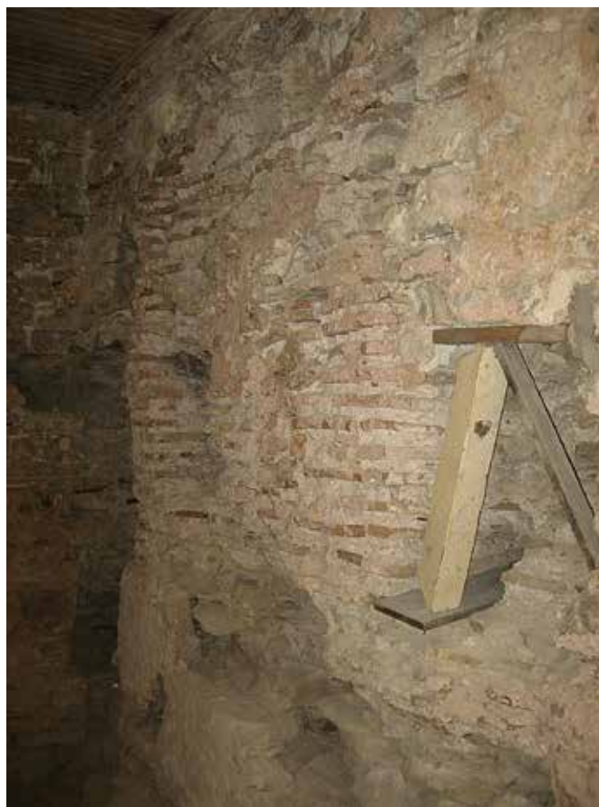
Sl. 21. Istočni zid stana predstavlja zapadno pročelje dvorane 6A. Gornji dio zidan je opekom, a donji je od kamena.
