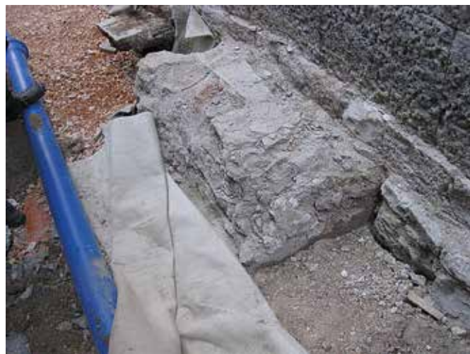
Sl. 12. Sonda br. 5, unutarne lice istočnog zida dvorane za audijencije
