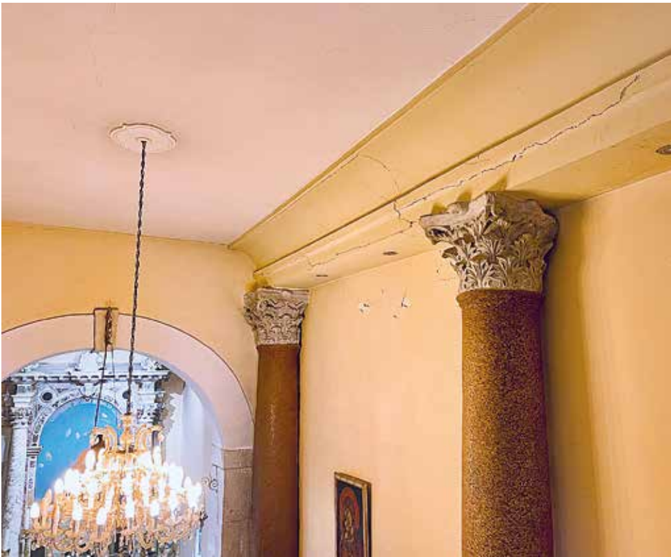
Slika 11. Unutrašnjost crkve sv. Stjepana, pogled prema istoku i zapadu. Na bočnim stranama vidljivi su stupovi koji su nekada bili u Dioklecijanovoj palači. (Fotografirao autor)
