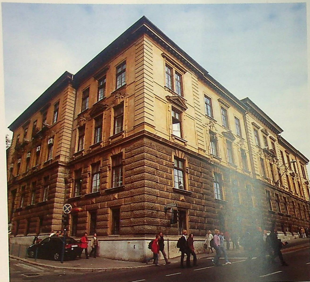
Pogled na zgradu Visoke pomorske škole i Odjela za pomorstvo
