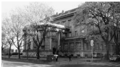
SLIKA 1. Zgrada PMF-a, Marulićev trg 19, Zagreb, oko 1982. (1, str. 36)
