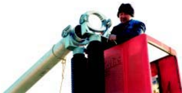
Slika 12. Slike sa montaže cijevnih sabirnica
