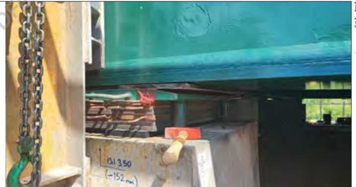
Slika 11. Primjer kliznog, teflonskog ležaja i čeličnih podložki
