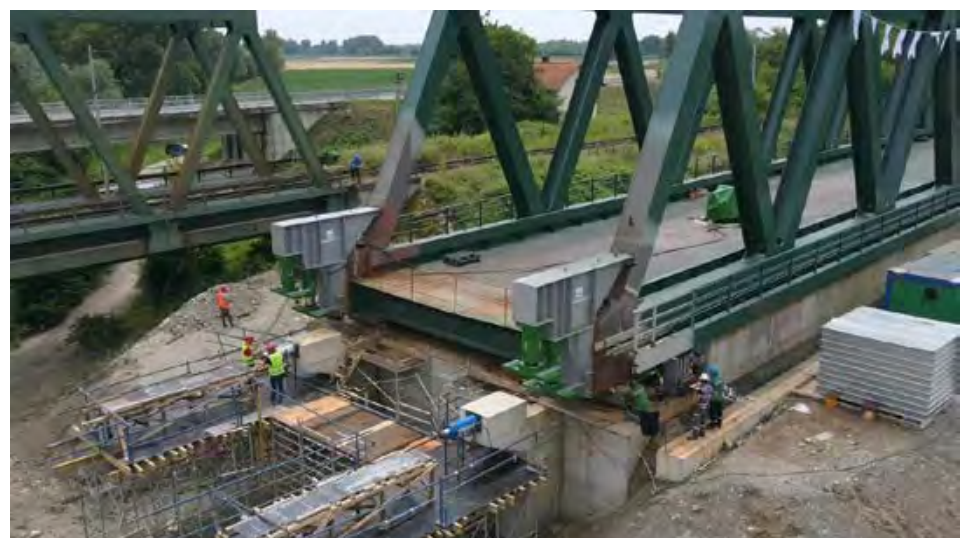
Slika 14. Šuplje dizalice, potezni blok i radni plato sa skelom
