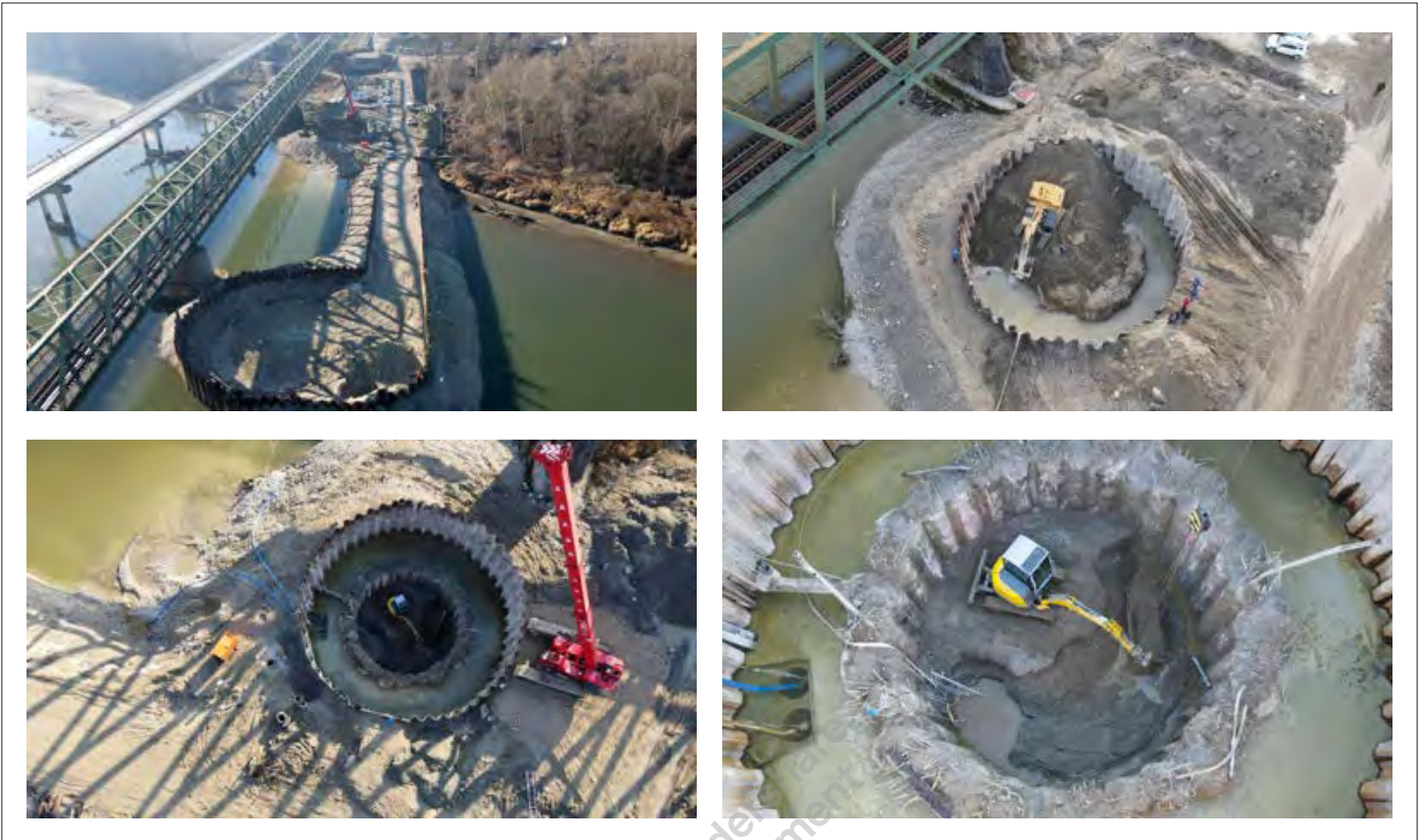
Slika 4. Čelične talpe i strojni iskop bunara za temeljenje stupova
