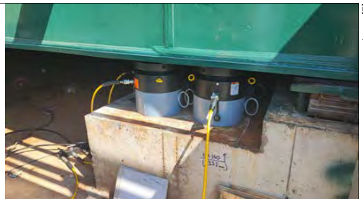
Slika 12. Bočne vodilice i hidraulične dizalice za podizanje mosta na platou
