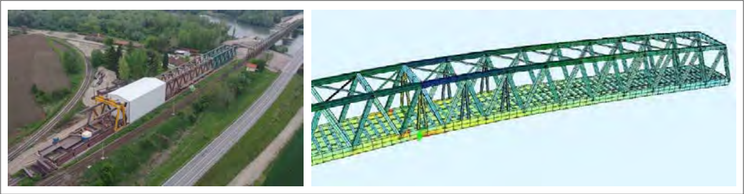
Slika 6. Sastavljanje dijelova konstrukcije na montažnome platou i pokretni zaštitni hangar [4]; privremene vertikale za reduciranje napona uslijed otklona pri potiskivanju
