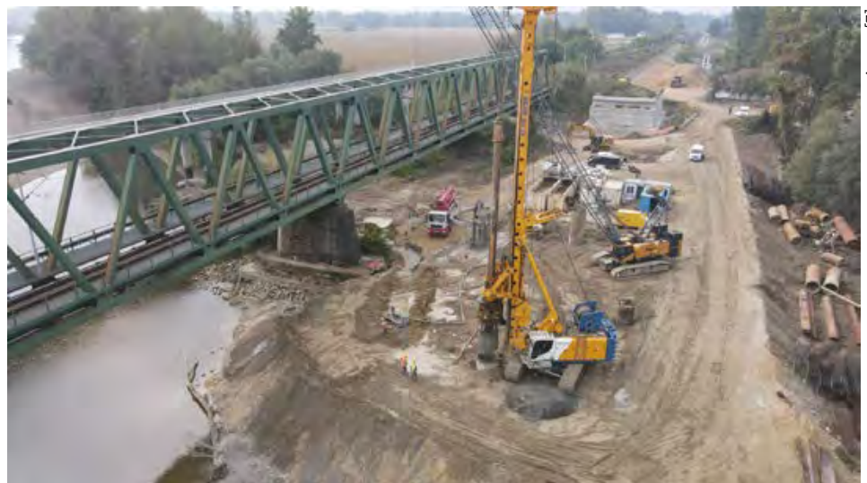
Slika 3. Privremeni nasip u koritu rijeke Drave i bušenje pilota za temelj stupa S1 [3]
