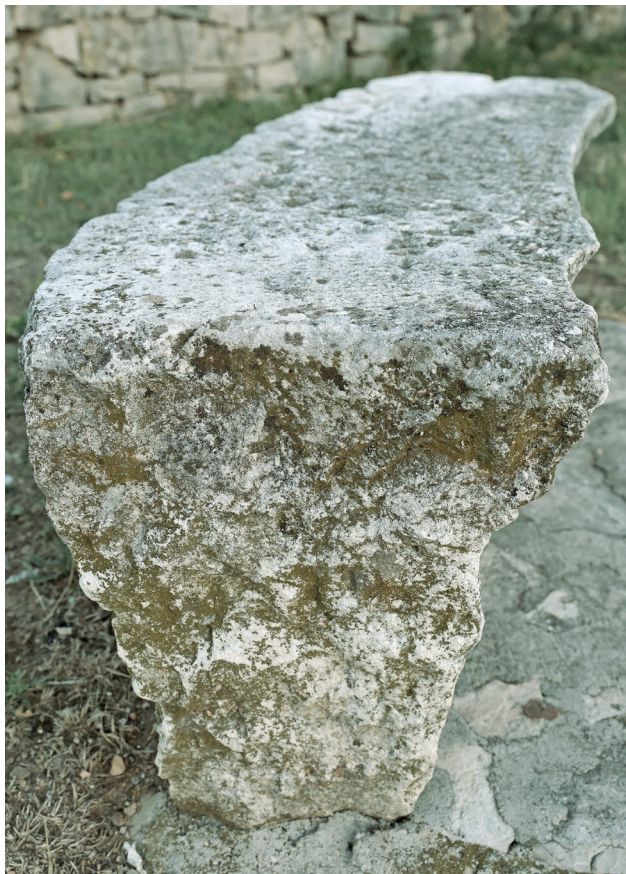
Slika 8 Lijeva, nepravilno odlomljena strana grede
