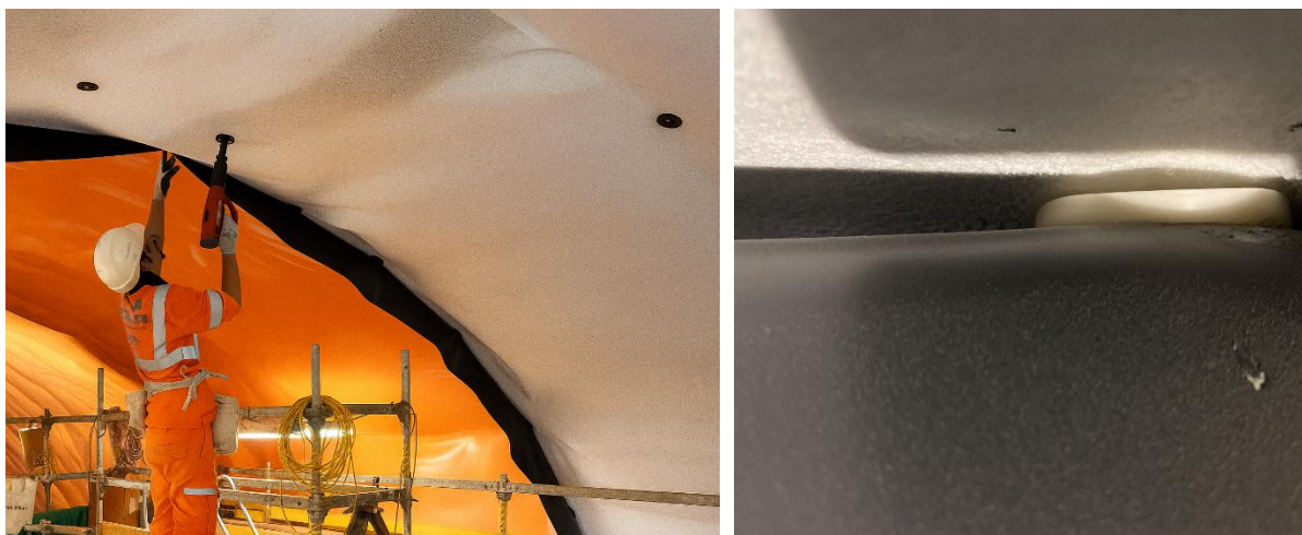
Slika 2. Prikaz pričvršćivanja zaštitnog filca i hidroizolacijske membrane [3]
