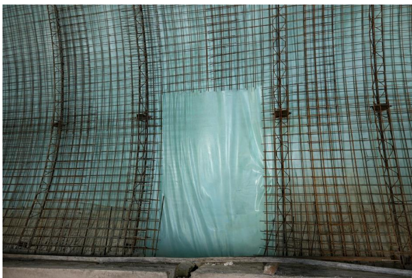
Slika 7. Prikaz hidroizolacije unutar revizione niše, tunel "Kobilja Glava" [5]
