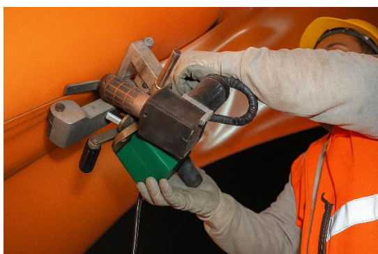
Slika 4. Prikaz dvostrukog vara [4]
