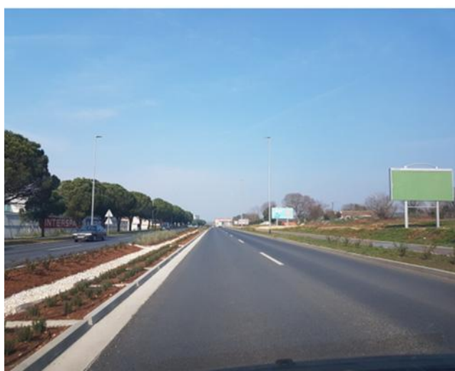
Slika 6. Gradska obilaznica u izgradnji i nakon sadnje (Starum) [10]
