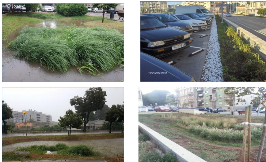
Slika 5. Izgrađeni NbS sustavi Navorove ulice (Starum) [6]
