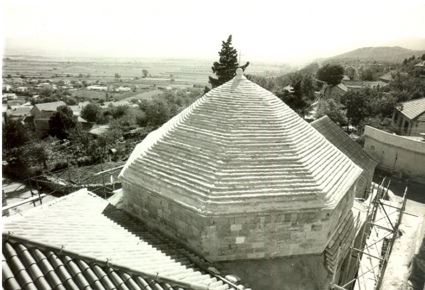
Sl. 10. Obnovljena kupola (MK – UZKB – KOS, Inv. br.97093, Goran Nikšić, Kupola pokrivena kamenim pločama, 7. 9. 1990.)
