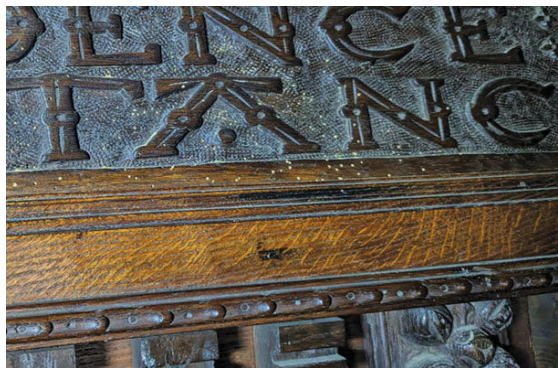
Slika 2. Izlazne rupice uzrokovane aktivnostima drvotočca. Fotografirala Ines Kokor Klapša (travanj 2023.).
