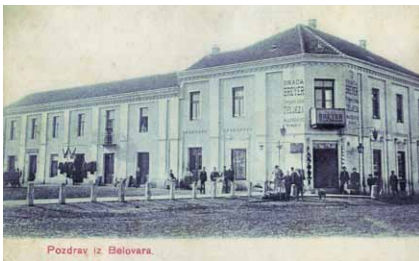
Slika 8. Trgovina braće Breyer, ugao Starog sajmišta i Križevačke ceste (razglednica, početak 20. stoljeća)
