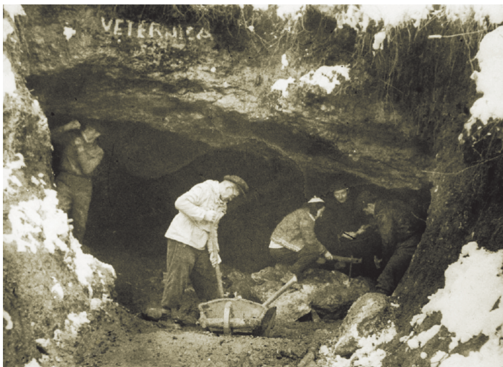
Radovi na ulaznom dijelu špilje Veternice 1950.
