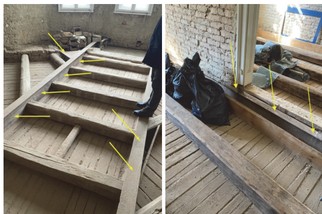
Slika 5. Čelični grednici međukatne konstrukcije kod klasične donjogradske uglovnice u zoni erkera i čelične grede ispod pregradnih zidova
