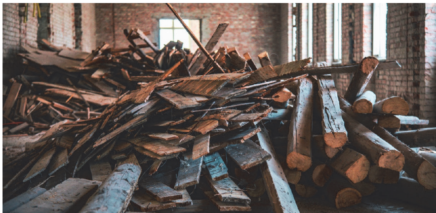
Slika 32. Demontirani drveni glavni nosivi elementi u konstrukcijskoj obnovi
