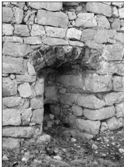
Sl. 13. Kaštel u Ražancu, strijelnica na uzdužnom zidu
