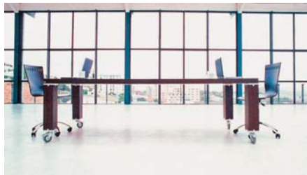
SLIKA 3 - Samoizravnavajući podni mortovi stvaraju monolitne površine bez vidljivih granica nanašanja
