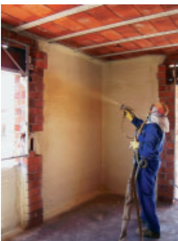
SLIKA 7. Toplinska izolacija s pomoću nove poliuretanske izolacijske pjene
