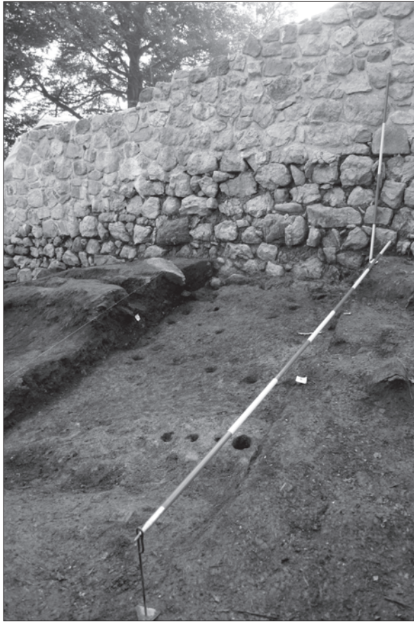
Sl. 2. Klenovec Humski-Plemički grad Vrbovec, ukopi stupova u živoj stijeni u zapadnoj sondi (□ A5/A6) uz zid SJ 062 (snimila T. Tkalčec)
